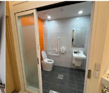
높이조절이 가능한 세면대와 자동문이 설치된 화장실
